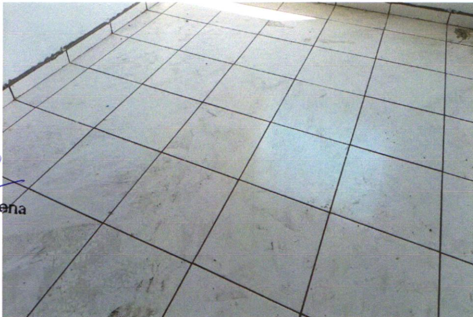
FOTO 16 - REVESTIMENTO CERÂMICO PARA PISO COM PLACAS TIPO ESMALTADA EXTRA DE DIMENSÕES 45X45 CM APLICADA EM AMBIENTES DE ÁREA ENTRE 5 M2 E 10 M2.
