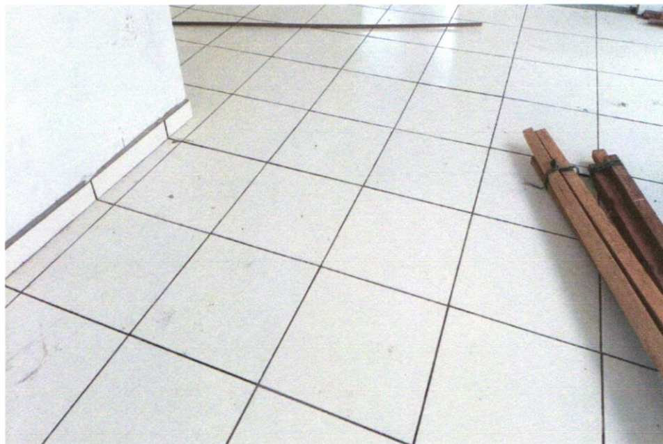
FOTO 17 - REVESTIMENTO CERÂMICO PARA PISO COM PLACAS TIPO ESMALTADA EXTRA DE DIMENSÕES 45X45 CM APLICADA EM AMBIENTES DE ÁREA ENTRE 5 M2 E 10 M2. AF_06/2014
