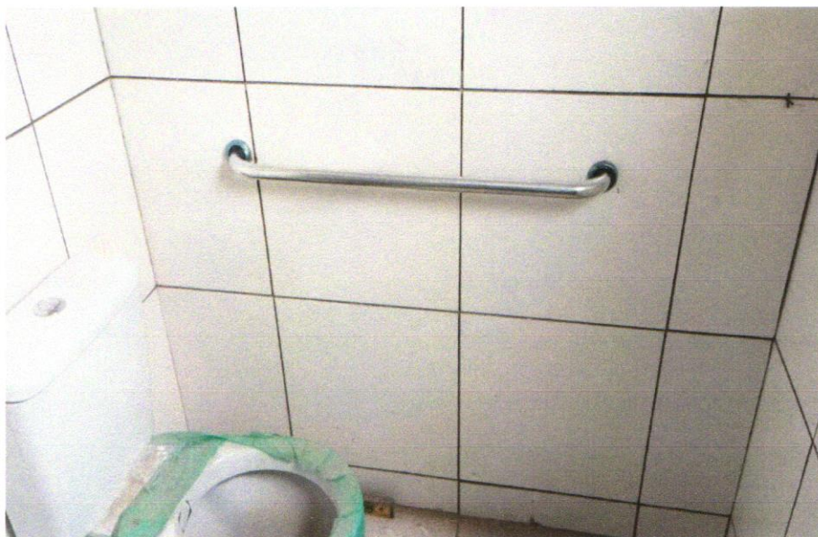
FOTO 29 - BARRA DE APOIO RETA, EM ALUMÍNIO, COMPRIMENTO 60 CM, FIXADA NA PAREDE - FORNECIMENTO E INSTALAÇÃO. AF_01/2020
