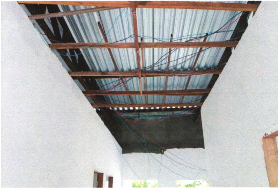
FOTO 05 - CABO DE COBRE FLEXÍVEL ISOLADO, 2,5 MM 2 , ANTI-CHAMA 450/750 V, PARA CIRCUITOS TERMINAIS - FORNECIMENTO E INSTALAÇÃO. AF_12/2015
