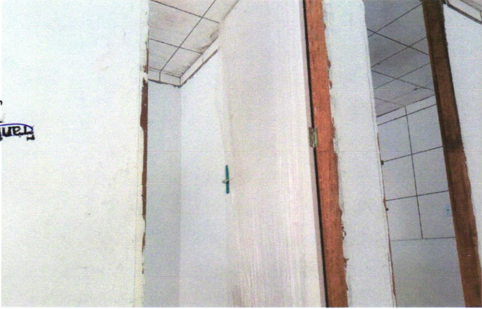
FOTO 23 - KIT DE PORTA-PRONTA DE MADEIRA EM ACABAMENTO MELAMÍNICO BRANCO, FOLHA LEVE OU MÉDIA, 90X210CM, EXCLUSIVAMENTE FECHADURA, FIXAÇÃO COM PREENCHIMENTO PARCIAL DE ESPUMA EXPANSIVA - FORNECIMENTO E INSTALAÇÃO. AF_12/2019
