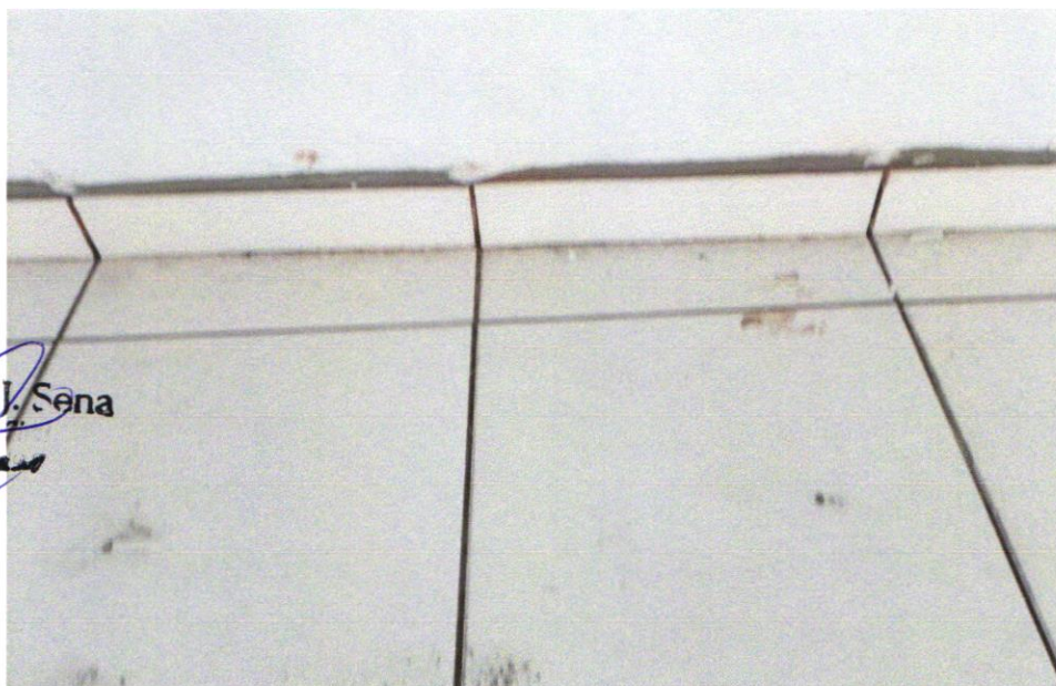
FOTO 21 - RODAPÉ CERÂMICO DE 7CM DE ALTURA COM PLACAS TIPO ESMALTADA COMERCIAL DE DIMENSÕES 35X35CM (PADRAO POPULAR). AF_06/2017
