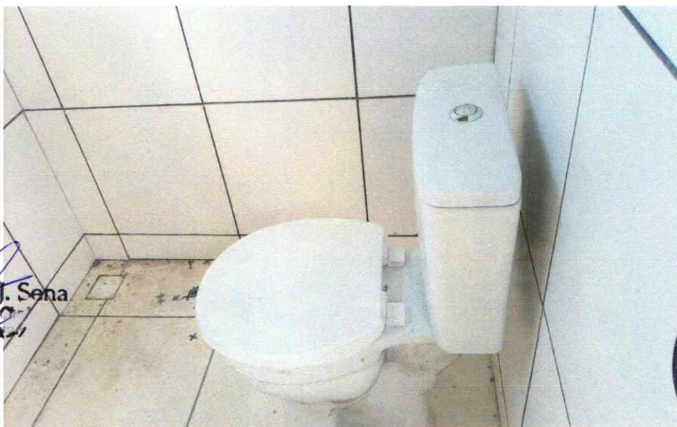
FOTO 14 - VASO SANITARIO SIFONADO CONVENCIONAL COM LOUÇA BRANCA, INCLUSO CONJUNTO DE LIGAÇÃO PARA BACIA SANITÁRIA AJUSTÁVEL - FORNECIMENTO E INSTALAÇÃO. AF_10/2016
