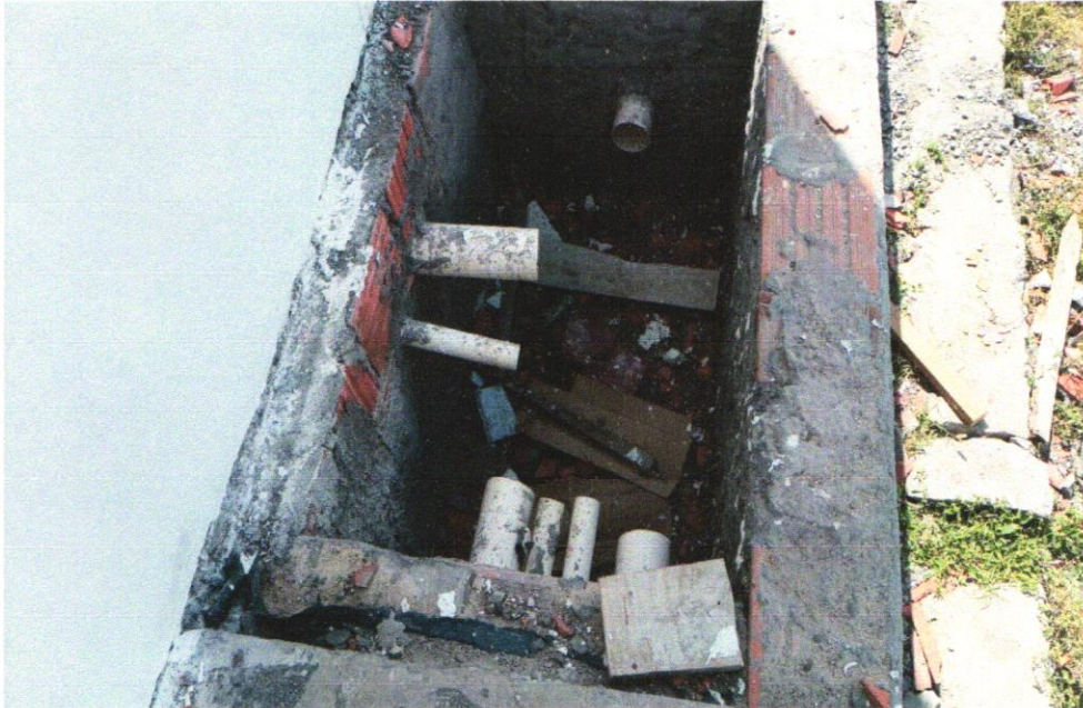
FOTO 13 - TUBO DE PVC BRANCO PARA REDE COLETORA DE ESGOTO CONDOMINIAL DE PAREDE MACIÇA, DN 100 MM, JUNTA ELÁSTICA - FORNECIMENTO E ASSENTAMENTO. AF_01/2021
