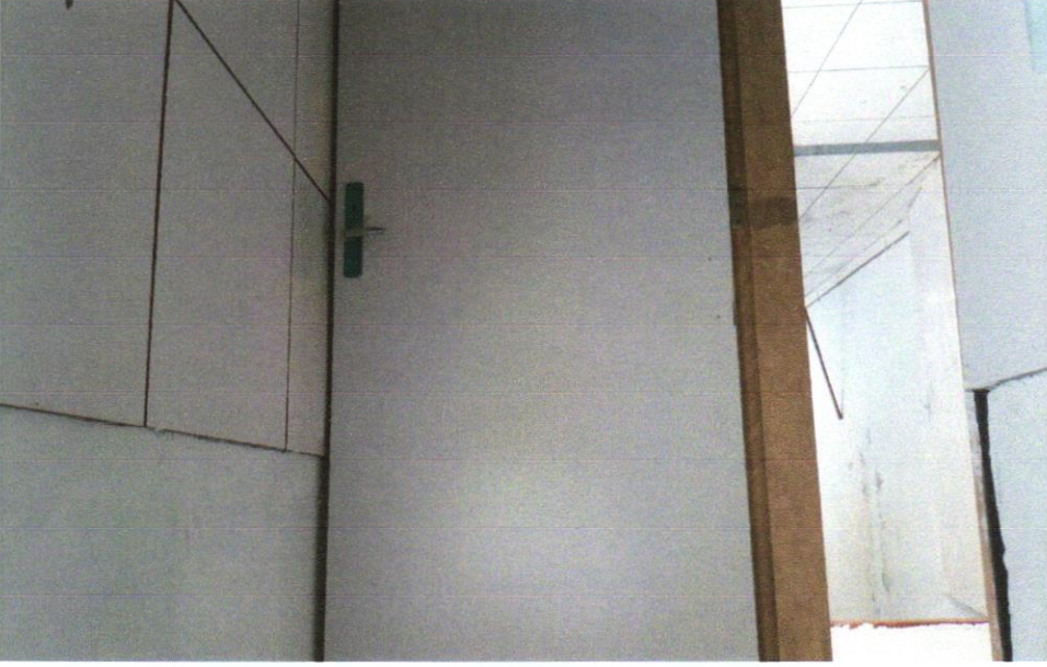
FOTO 23 - KIT DE PORTA-PRONTA DE MADEIRA EM ACABAMENTO MELAMÍNICO BRANCO, FOLHA LEVE OU MÉDIA, 90X210CM, EXCLUSIVAMENTE FECHADURA, FIXAÇÃO COM PREENCHIMENTO PARCIAL DE ESPUMA EXPANSIVA - FORNECIMENTO E INSTALAÇÃO. AF_12/2019
