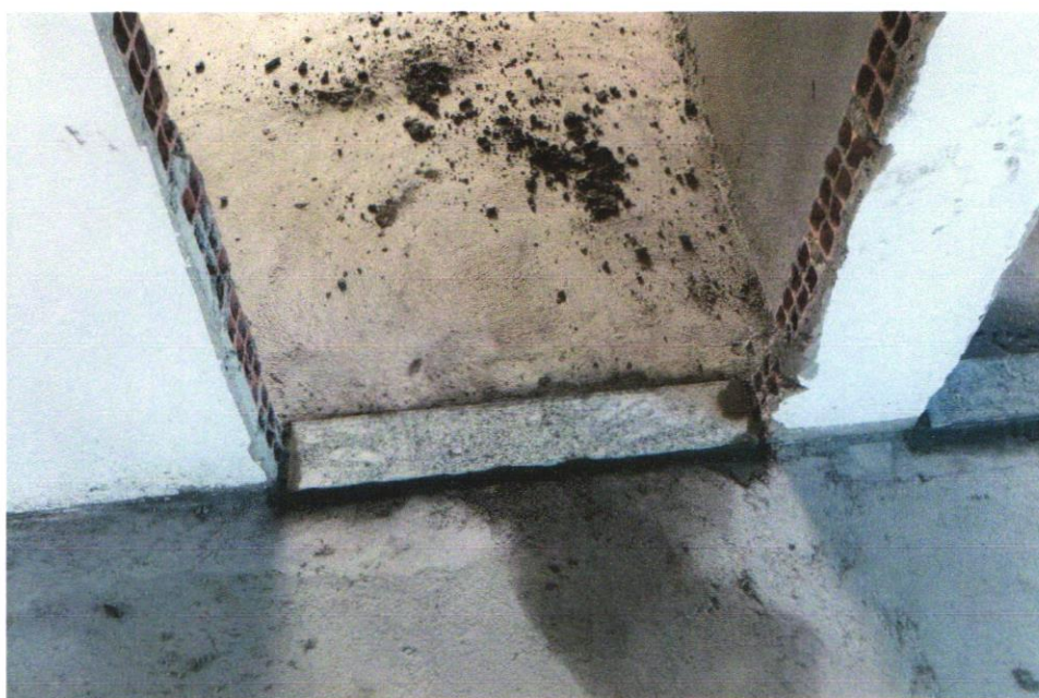
FOTO 22 - SOLEIRA EM GRANITO, LARGURA 15 CM, ESPESSURA 2,0 CM. AF_09/2020
