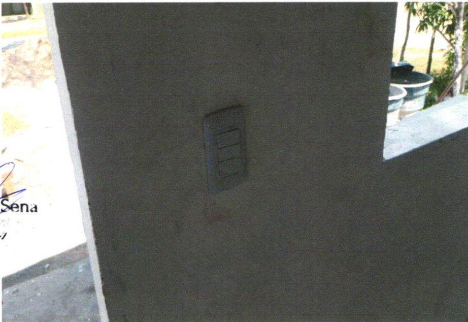
FOTO 06 - INTERRUPTOR SIMPLES (3 MÓDULOS), 10A/250V, INCLUINDO SUPORTE E PLACA - FORNECIMENTO E INSTALAÇÃO. AF_12/2015
