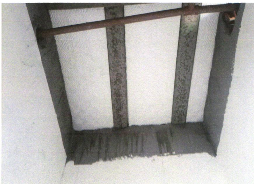
FOTO 01 – Laje pré-fabricada treliçada para piso ou cobertura, intereixo 38cm, h=12cm, el. enchimento em EPS h=8cm, inclusive escoramento em madeira e capeamento 4cm.
