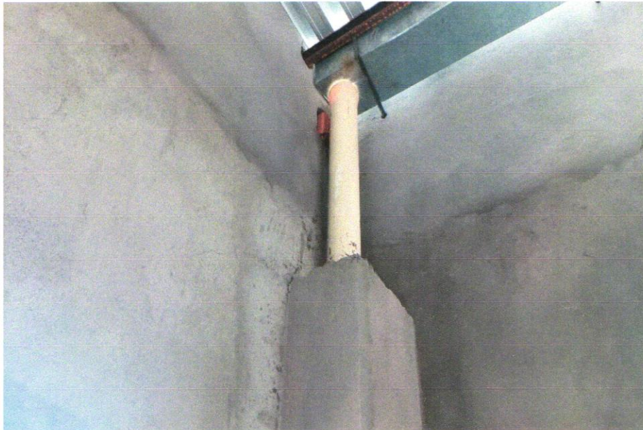
FOTO 03 - TUBO PVC, SÉRIE R, ÁGUA PLUVIAL, DN 100 MM, FORNECIDO E INSTALADO EM RAMAL DE ENCAMINHAMENTO. AF_06/2022
