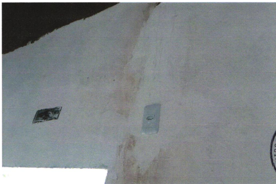
FOTO 10 - TOMADA ALTA DE EMBUTIR (1 MÓDULO), 2P+T 20 A, INCLUINDO SUPORTE E PLACA - FORNECIMENTO E INSTALAÇÃO. AF_12/2015
