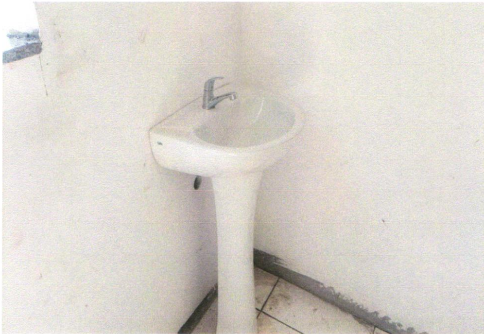
FOTO 15 - LAVATÓRIO LOUÇA BRANCA COM COLUNA, *44 X 35,5* CM, PADRÃO POPULAR, INCLUSO SIFÃO FLEXÍVEL EM PVC, VÁLVULA E ENGATE FLEXÍVEL 30CM EM PLÁSTICO E COM TORNEIRA CROMADA PADRÃO POPULAR - FORNECIMENTO E INSTALAÇÃO. AF_01/2020
