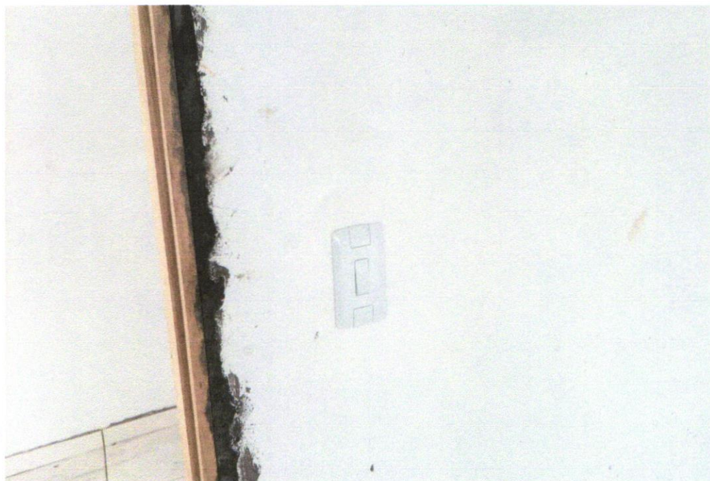
FOTO 07 - INTERRUPTOR SIMPLES (1 MÓDULO), 10A/250V, INCLUINDO SUPORTE E PLACA - FORNECIMENTO E INSTALAÇÃO. AF_12/2015
